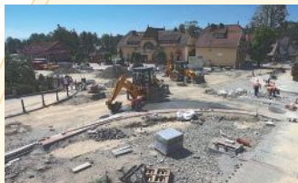
Rondo przy dworcu PKP – prace
