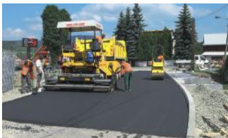
Most na ul. Kasprowicza – prace
