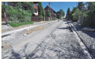
ul. Poniatowskiego – prace
