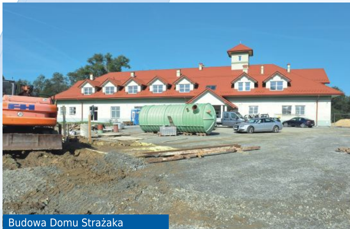
Budowa Domu Strażaka
