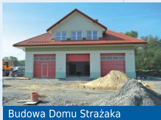
Budowa Domu Strażaka
