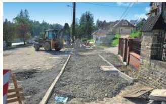
Dworzec autobusowy – prace
