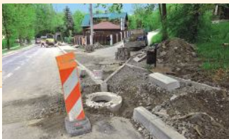
ul. Chopina – prace
