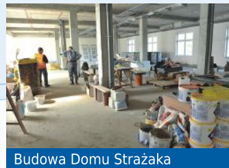
Budowa Domu Strażaka
