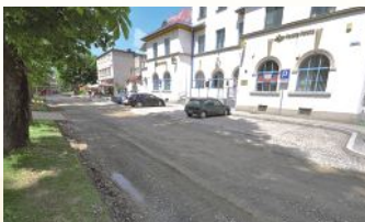
ul. Orkana – prace
